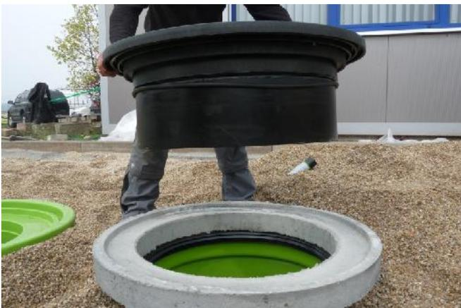
Bild 11: Abdeckung EASY, Dichtung, Betonring, Teleskop-Schachtverlängerung, Deckel
