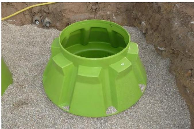
Bild 3: Schacht MEDIUM beim Einbau
